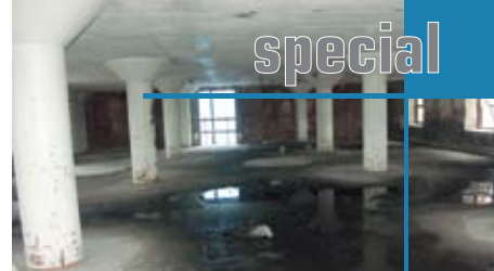
Här kommer det bli nya fräscha lägenheter i Warehouse-stil.
