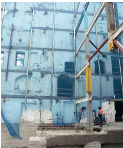
Ovan en Brokk 90 som bilar upp betongplattan och nedan Uno Hallgren med sin egen "Juvel".
