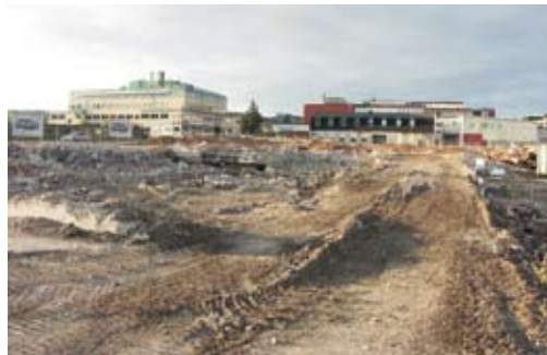
Inte Mycket kvar på Backaplan efter at Rivab rivit ett helt kvarter bestående av småindustrier, affärer, restauranger m m. Här ska byggas lägenheter.
